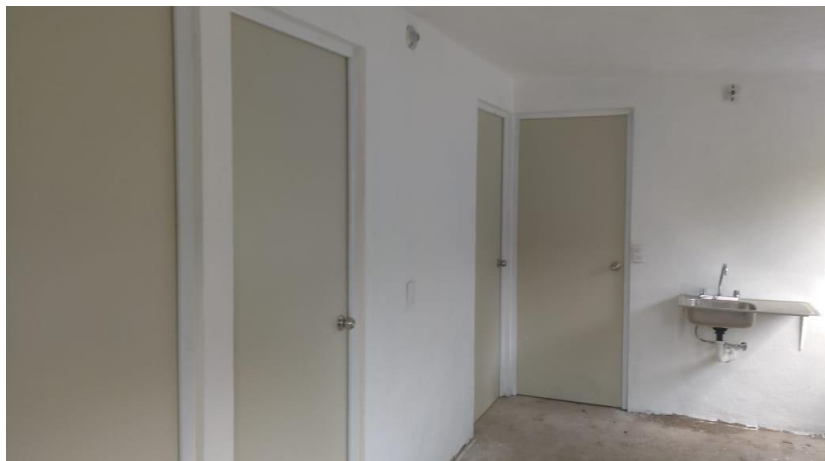
VISTA INTERIOR Y COLOCACIÓN DE TARJA
