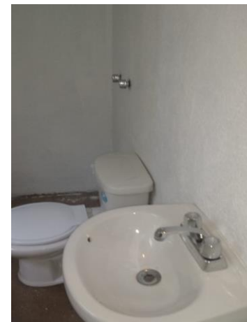
COLOCACIÓN DE MUEBLES DE BAÑO
