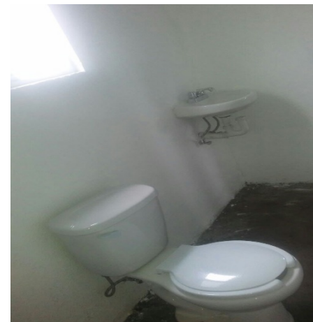
COLOCACIÓN DE MUEBLES DE BAÑO
