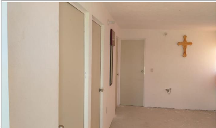
VISTA INTERIOR Y COLOCACIÓN DE TARJA
