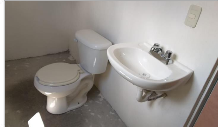
COLOCACIÓN MUEBLES DE BAÑO
