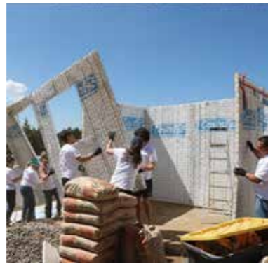
Alineado y anclaje
