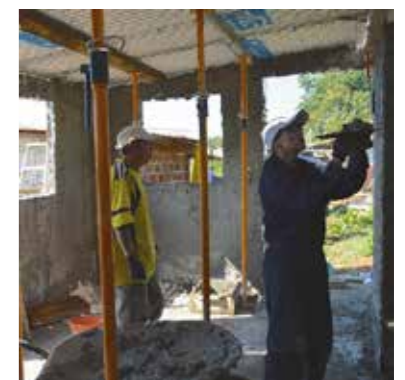
Repellado de muros
