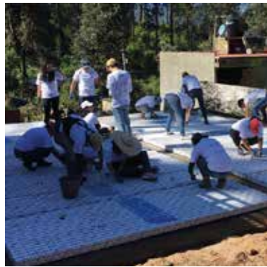
Ensamble y levantamiento de muros
