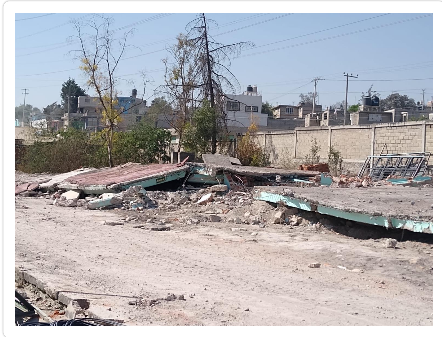
ANTES DE LA INTERVENCIÓN
