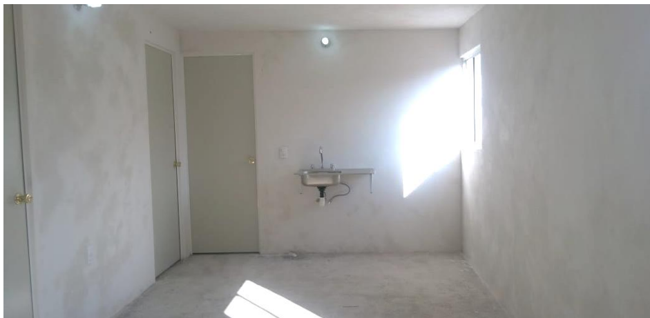
VISTA INTERIOR Y COLOCACIÓN DE TARJA
