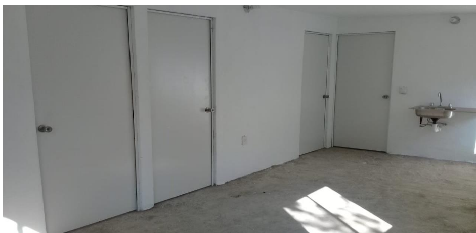
VISTA INTERIOR Y COLOCACIÓN DE TARJA
