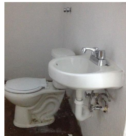
COLOCACIÓN DE MUEBLES DE BAÑO
