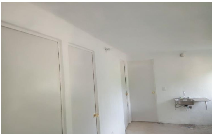
VISTA INTERIOR Y COLOCACIÓN DE TARJA
