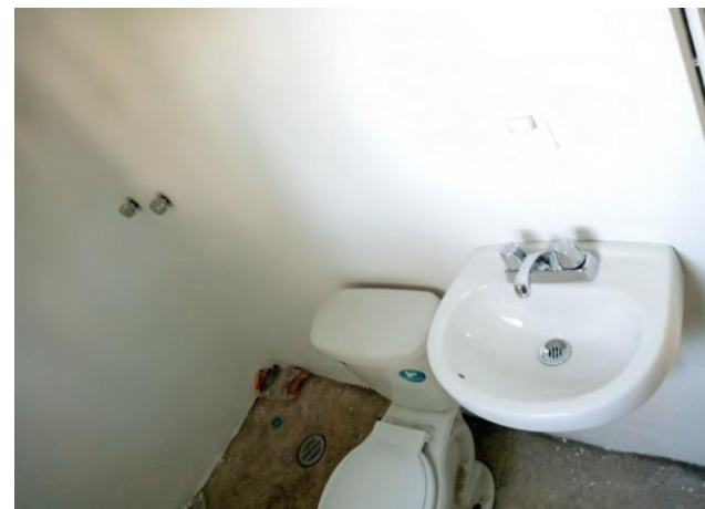
COLOCACIÓN DE MUEBLES DE BAÑO
