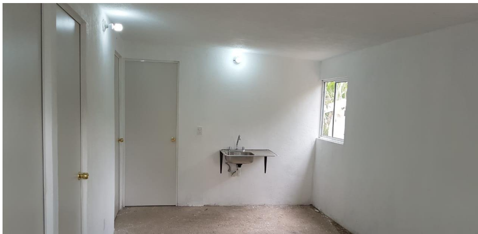
VISTA INTERIOR Y COLOCACIÓN DE TARJA
