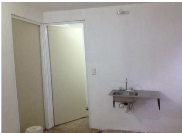
VISTA INTERIOR Y COLOCACIÓN DE TARJA
