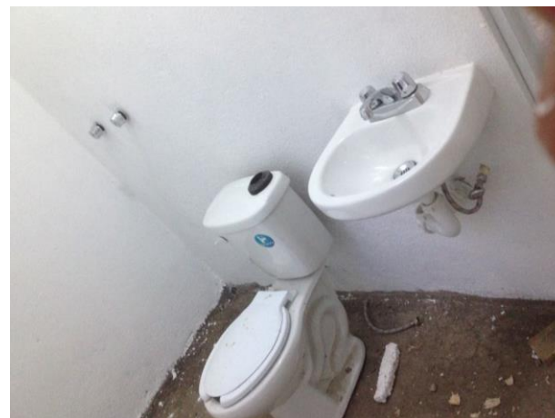
COLOCACIÓN DE MUEBLES DE BAÑO
