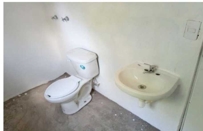
COLOCACION DE MUEBLES DE BAÑO
