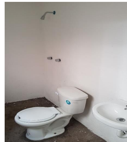
COLOCACION DE MUEBLES DE BAÑO
