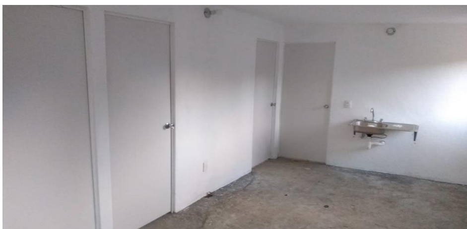
VISTA INTERIOR Y COLOCACIÓN DE TARJA
