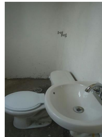
COLOCACION DE MUEBLES DE BAÑO
