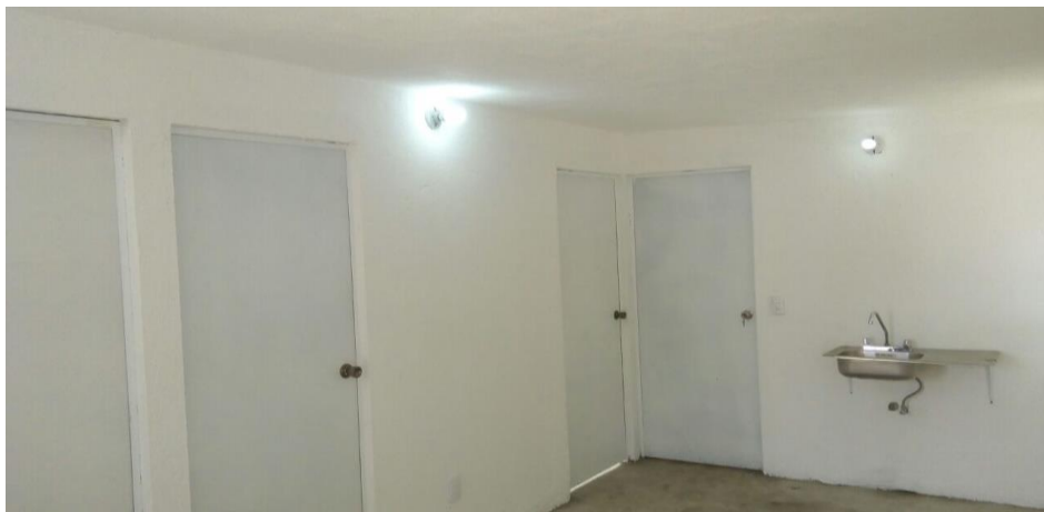
VISTA INTERIOR Y COLOCACION DE TARJA
