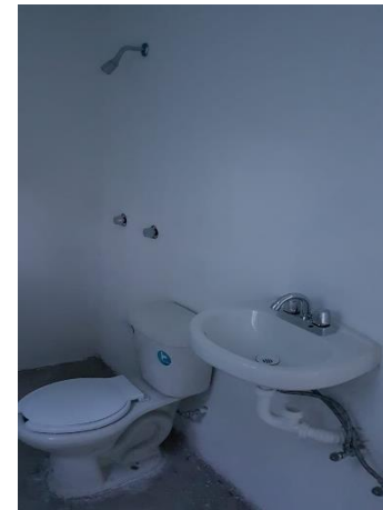
COLOCACIÓN DE MUEBLES DE BAÑO
