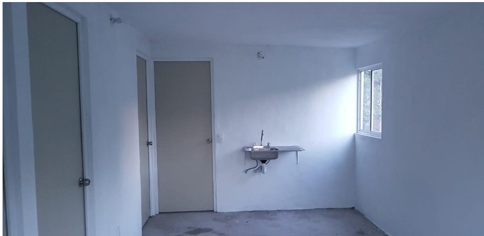
VISTA INTERIOR Y COLOCACIÓN DE TARJA
