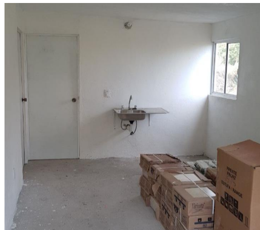
VISTA INTERIOR Y COLOCACION DE TARJA
