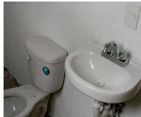
COLOCACIÓN DE MUEBLES DE BAÑO
