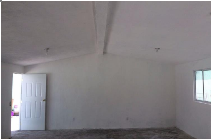
INTERIOR (COLOCACION DE CANCELERIA)
