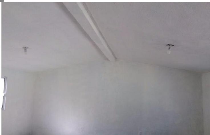
INTERIOR (COLOCACION DE INSTALACION ELECTRICA)
