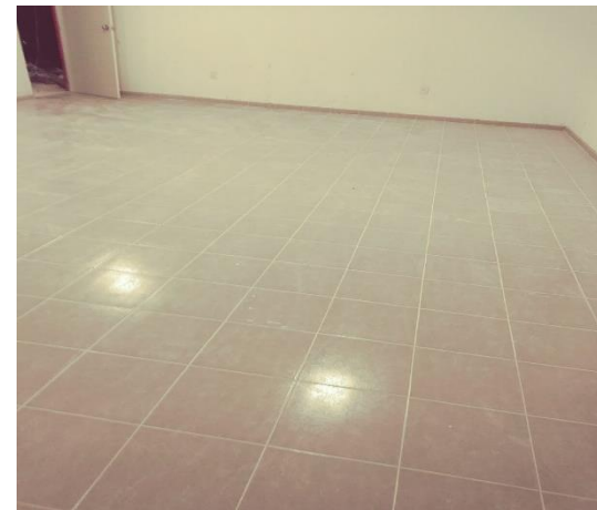
COLOCACIÓN DE LOSETA AULA 2
