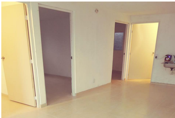
VISTA INTERIOR Y COLOCACIÓN DE TARJA
