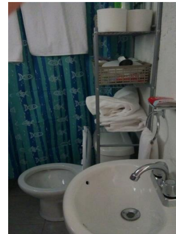
COLOCACIÓN MUEBLES DE BAÑO
