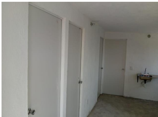
VISTA INTERIOR Y COLOCACIÓN DE TARJA
