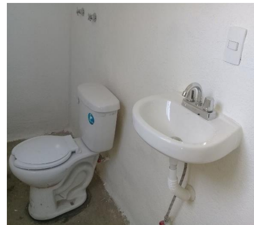
COLOCACIÓN DE MUEBLES DE BAÑO
