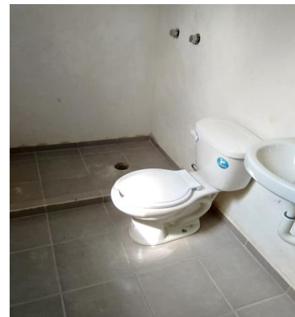
COLOCACIÓN DE MUEBLES DE BAÑO
