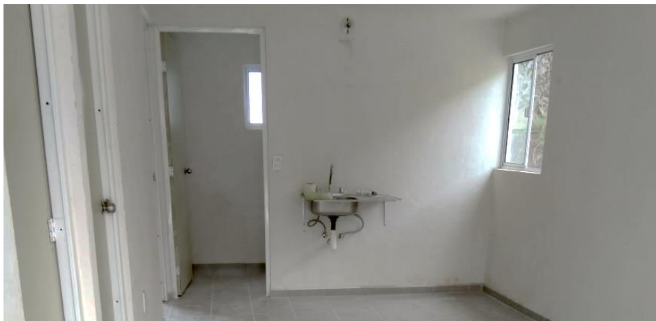
VISTA INTERIOR Y COLOCACIÓN DE TARJA
