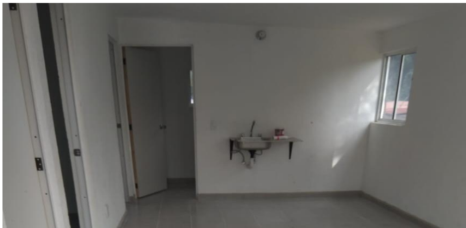
VISTA INTERIOR Y COLOCACIÓN DE TARJA
