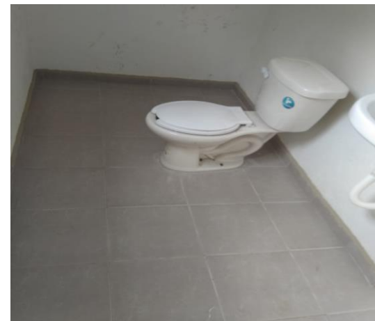
COLOCACIÓN DE MUEBLES DE BAÑO
