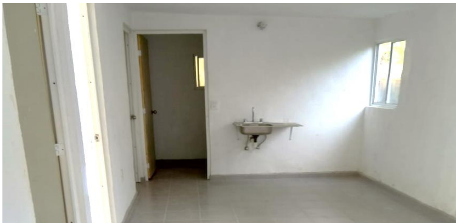
VISTA INTERIOR Y COLOCACIÓN DE TARJA
