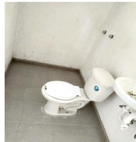
COLOCACIÓN DE MUEBLES DE BAÑO
