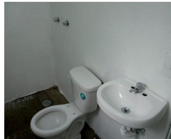
COLOCACIÓN DE MUEBLES DE BAÑO
