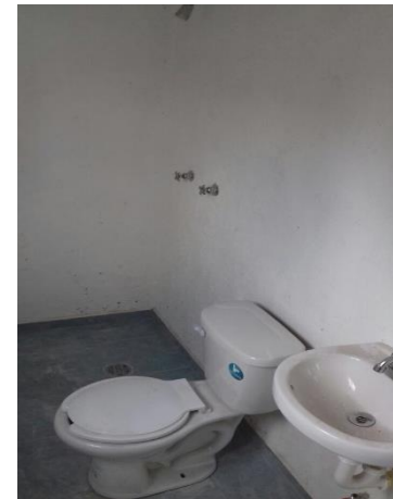
COLOCACION MUEBLES DE BAÑO
