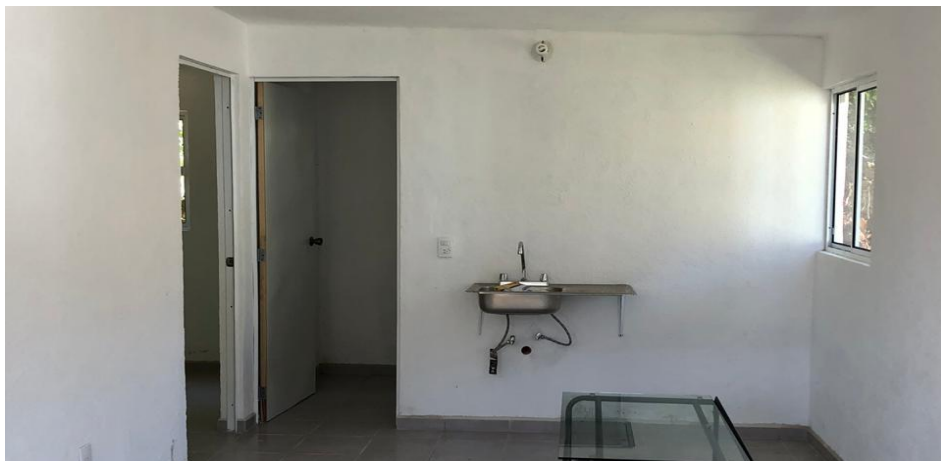
VISTA INTERIOR Y COLOCACIÓN DE TARJA
