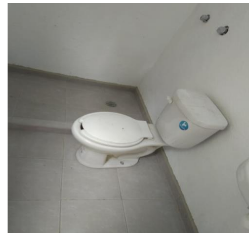
COLOCACIÓN DE MUEBLES DE BAÑO
