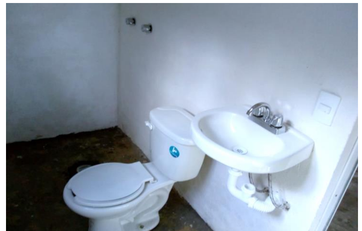
COLOCACIÓN MUEBLES DE BAÑO
