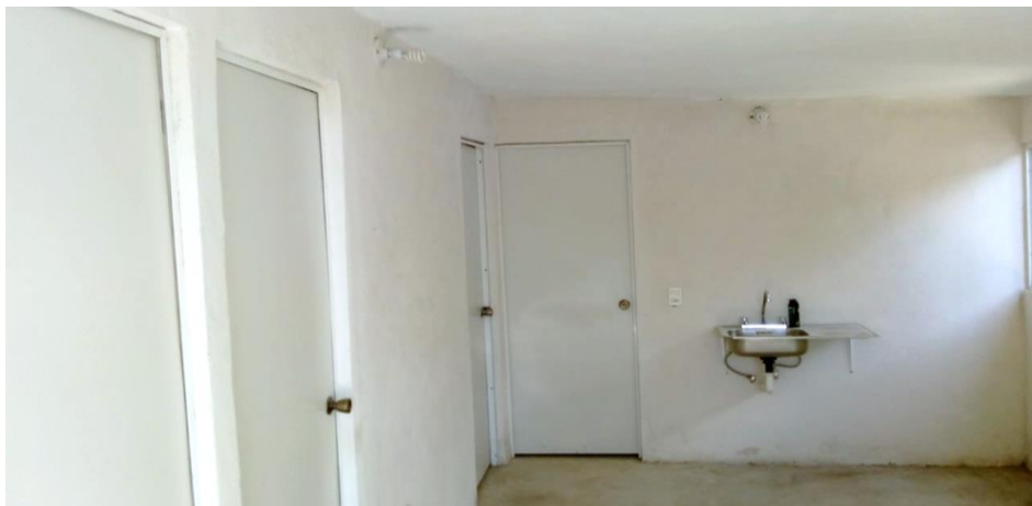
VISTA INTERIOR Y COLOCACION DE TARJA
