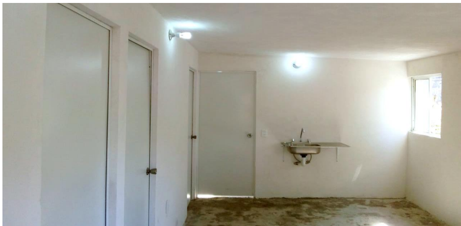
VISTA INTERIOR Y COLOCACION DE TARJA
