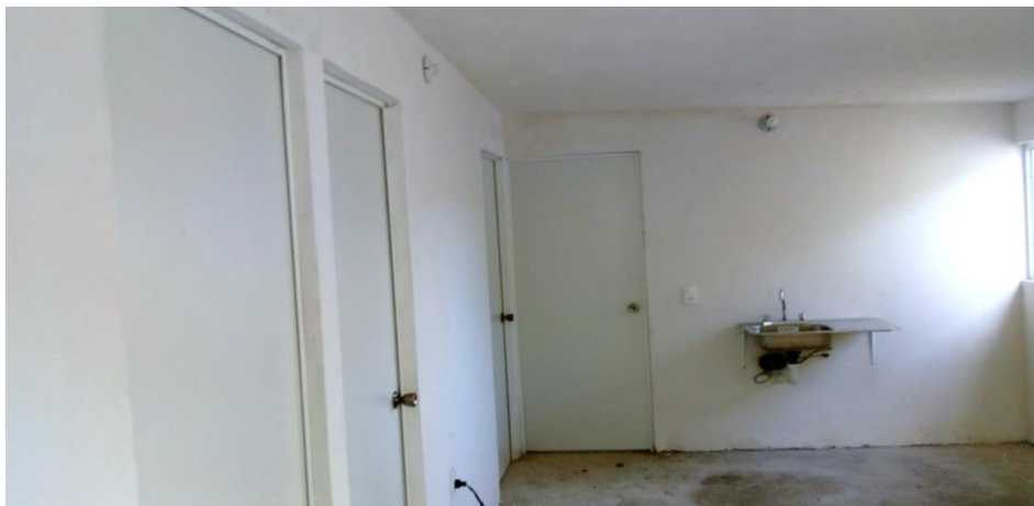
VISTA INTERIOR Y COLOCACION DE TARJA
