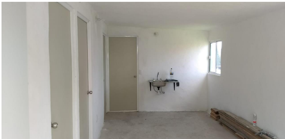
VISTA INTERIOR Y COLOCACIÓN DE TARJA
