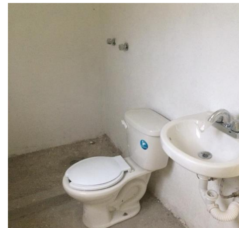
COLOCACIÓN DE MUEBLES DE BAÑO
