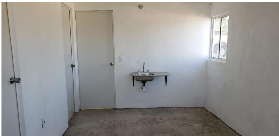
VISTA INTERIOR Y COLOCACIÓN DE TARJA
