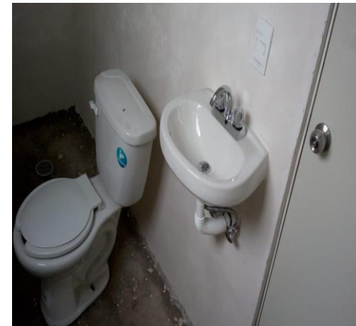
COLOCACIÓN DE MUEBLES DE BAÑO
