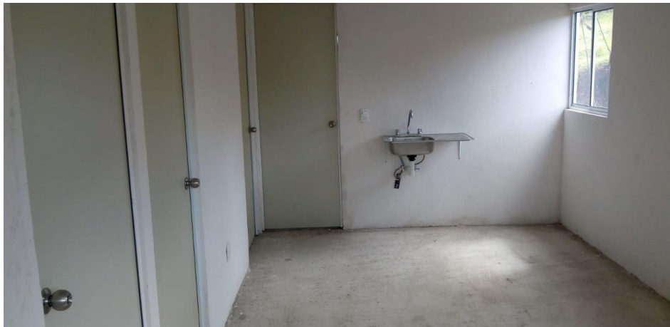
VISTA INTERIOR Y COLOCACIÓN DE TARJA
