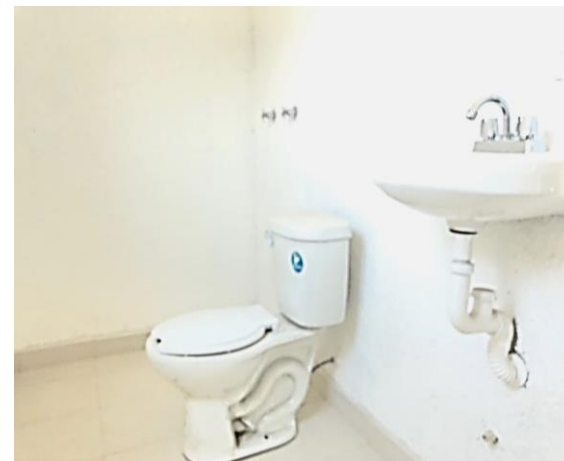
COLOCACION DE MUEBLES DE BAÑO
