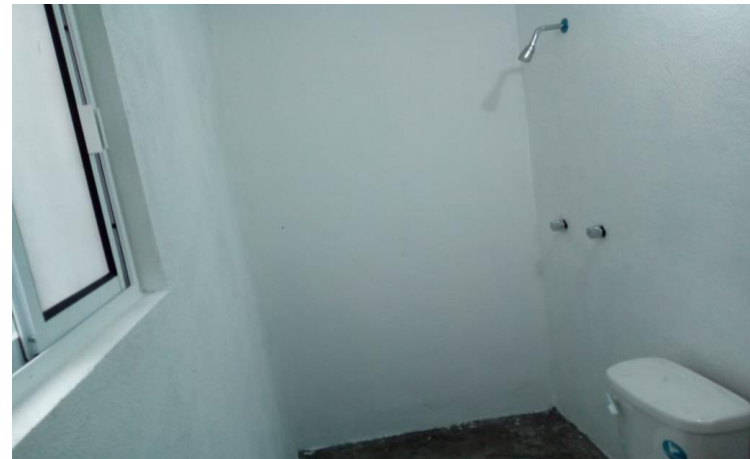
COLOCACIÓN DE MUEBLES DE BAÑO
