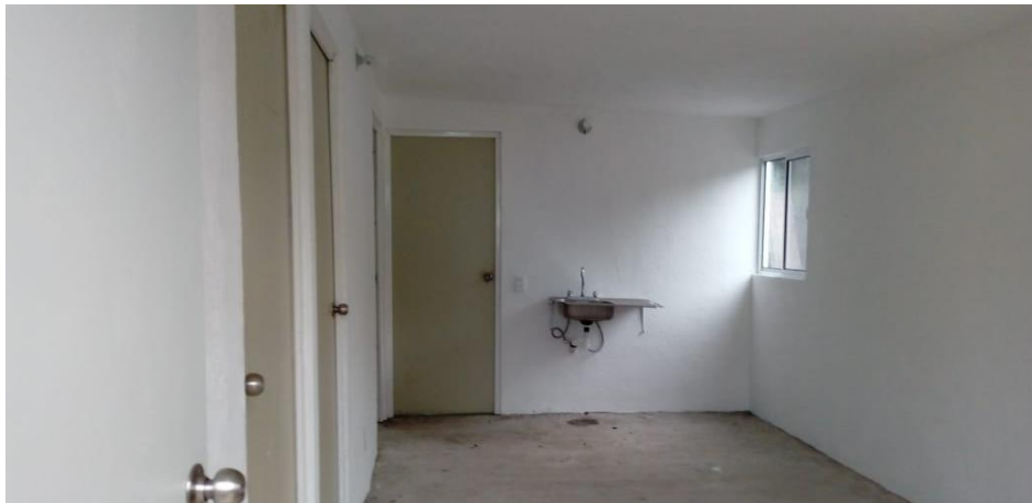
VISTA INTERIOR Y COLOCACIÓN DE TARJA
