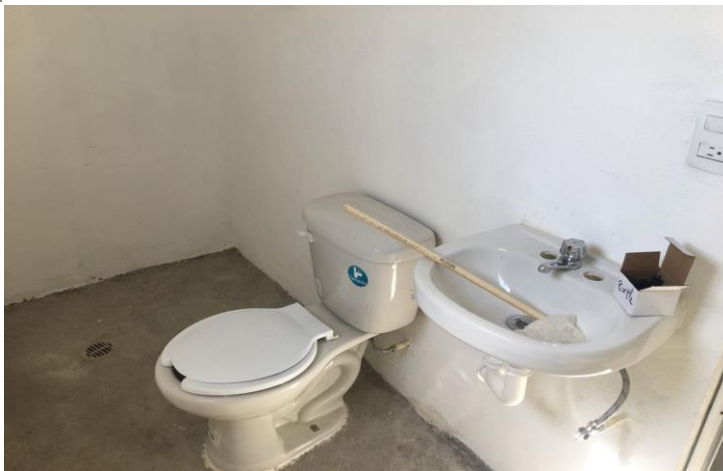
INTERIOR (COLOCACION DE MUEBLES DE BAÑO)
