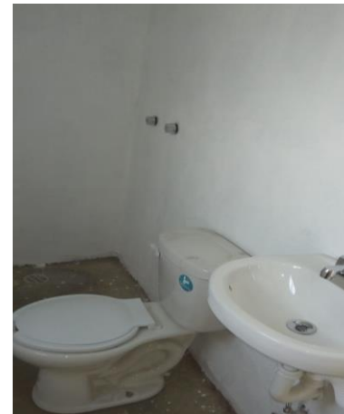
COLOCACIÓN DE MUEBLES DE BAÑO
