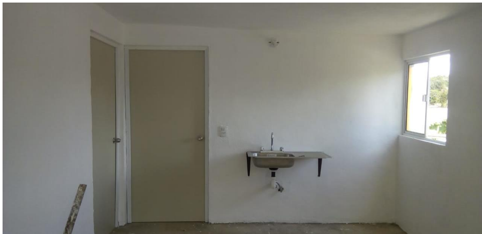
VISTA INTERIOR Y COLOCACIÓN DE TARJA
