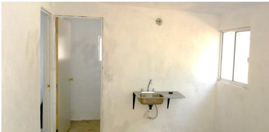
VISTA INTERIOR Y COLOCACION DE TARJA
