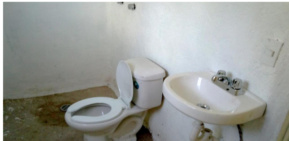
COLOCACIÓN DE MUEBLES DE BAÑO
