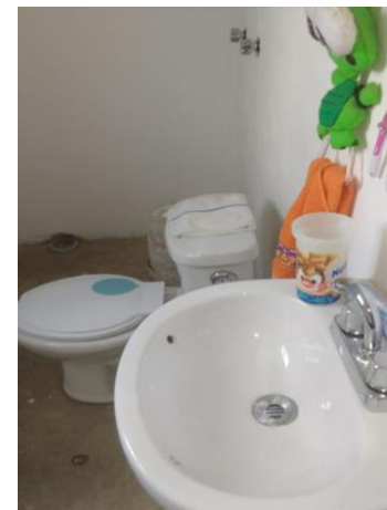
COLOCACIÓN DE MUEBLES DE BAÑO
