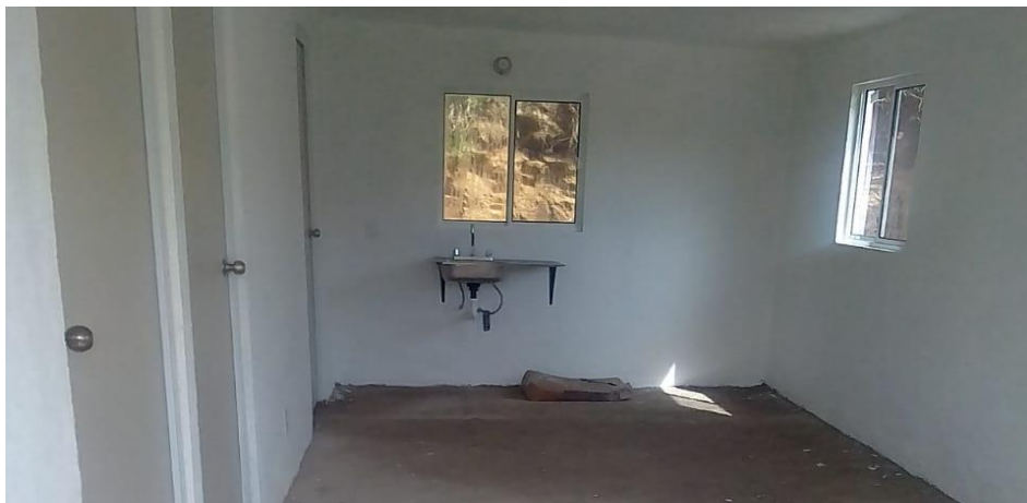
VISTA INTERIOR Y COLOCACION DE TARJA
