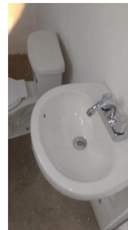
COLOCACIÓN DE MUEBLES DE BAÑO
