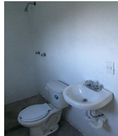
COLOCACIÓN DE MUEBLES DE BAÑO
