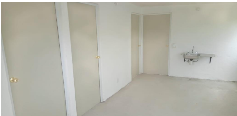
VISTA INTERIOR Y COLOCACION DE TARJA
