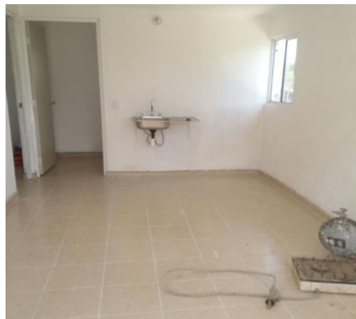
VISTA INTERIOR Y COLOCACION DE TARJA
