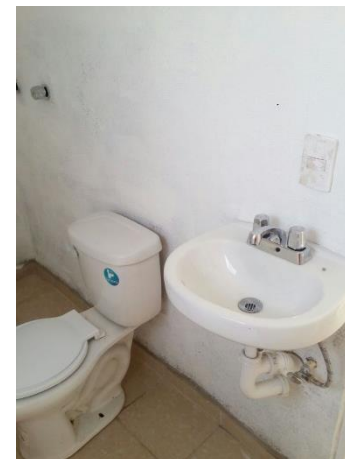
COLOCACIÓN DE MUEBLES DE BAÑO
