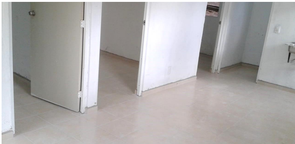
VISTA INTERIOR Y COLOCACION DE TARJA
