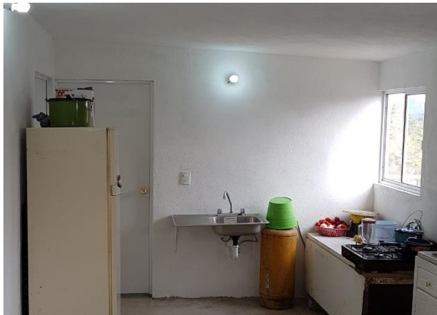
VISTA INTERIOR Y COLOCACION DE TARJA
