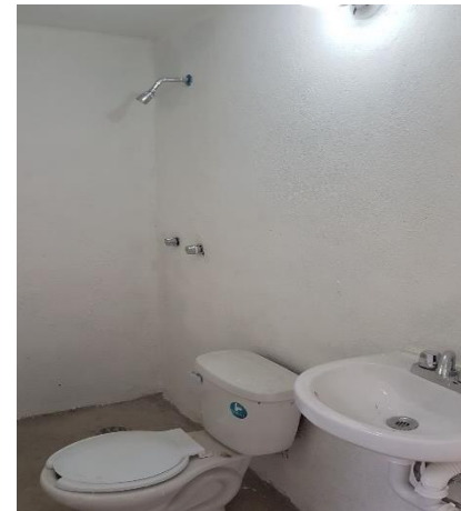
COLOCACION DE MUEBLES DE BAÑO
