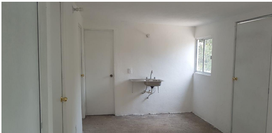
VISTA INTERIOR Y COLOCACION DE TARJA
