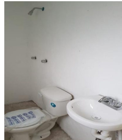
COLOCACIÓN DE MUEBLES DE BAÑO
