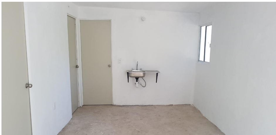
VISTA INTERIOR Y COLOCACIÓN DE TARJA
