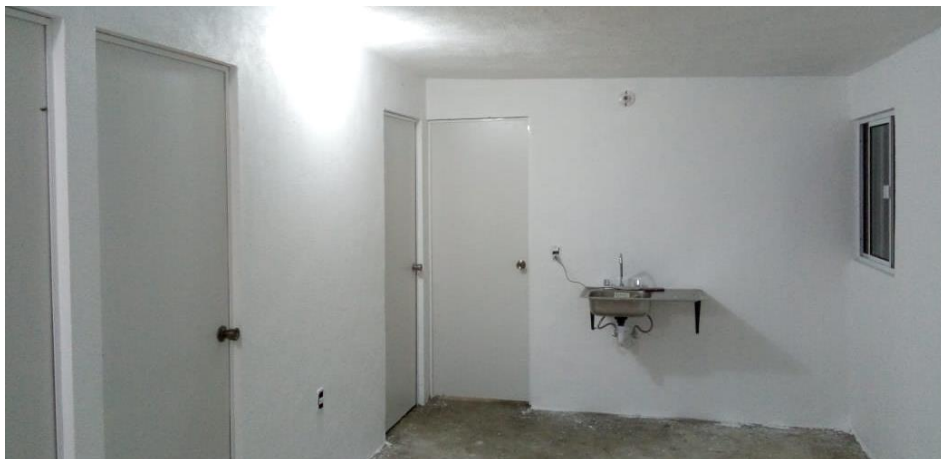
VISTA INTERIOR Y COLOCACIÓN DE TARJA
